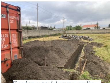
Fondamenta del nuovo mulino
